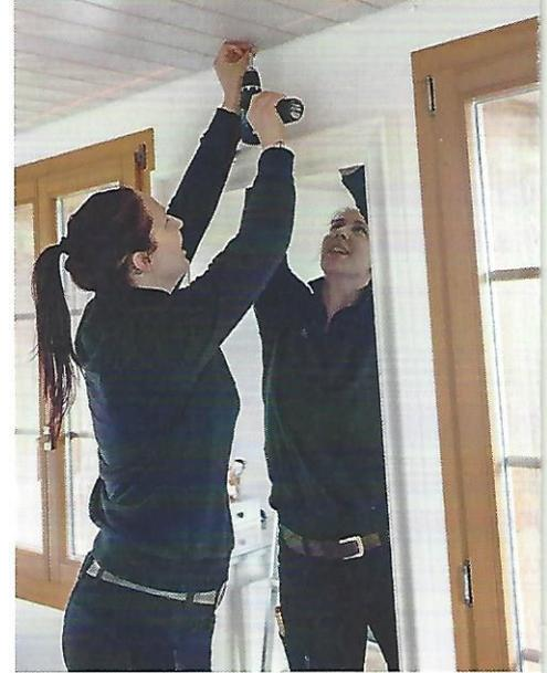
Simone Lanz installiert die Aufhänger für die Vorhangschiene mit Hilfe des Laser-Lots.
